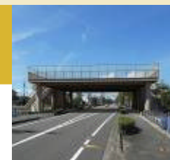
歩道橋型津波避難タワー
