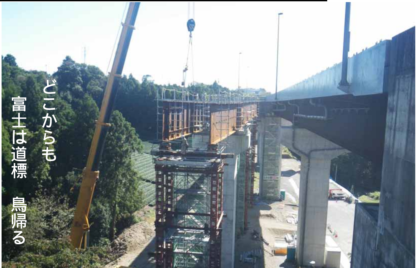
新東名高速道路と御前崎港を結ぶ国道473号の 橋梁工事～橋桁の架設～
