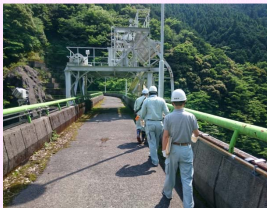
現地検査の状況(ダム天端)
