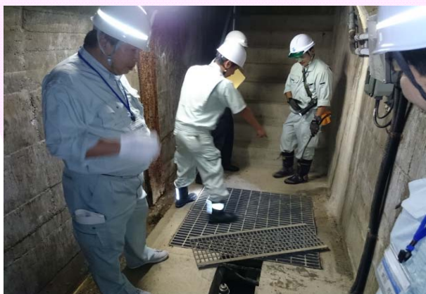
現地検査の状況(ダム監査廊)
