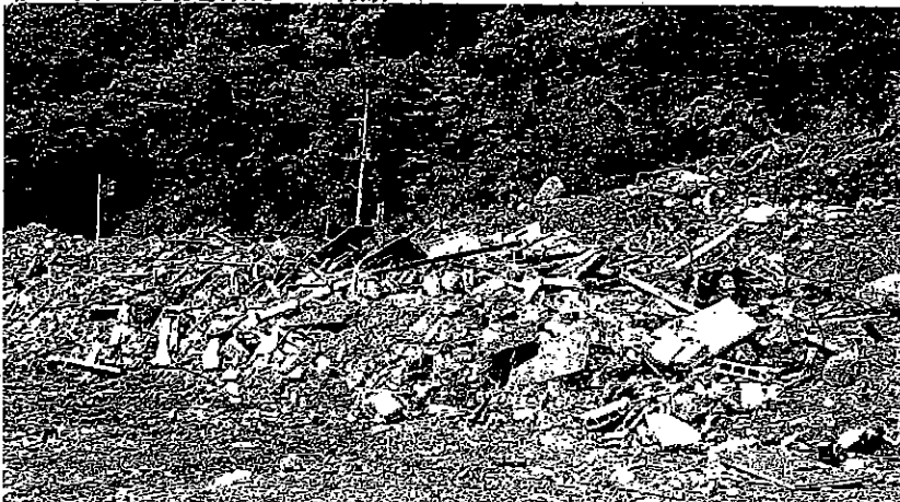
伊豆山の現場を東方から撮影
