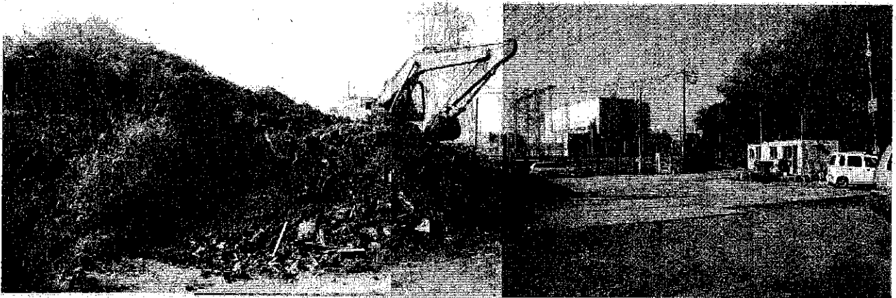
資材置き場全景（奥から入口方面に向かって撮影）
