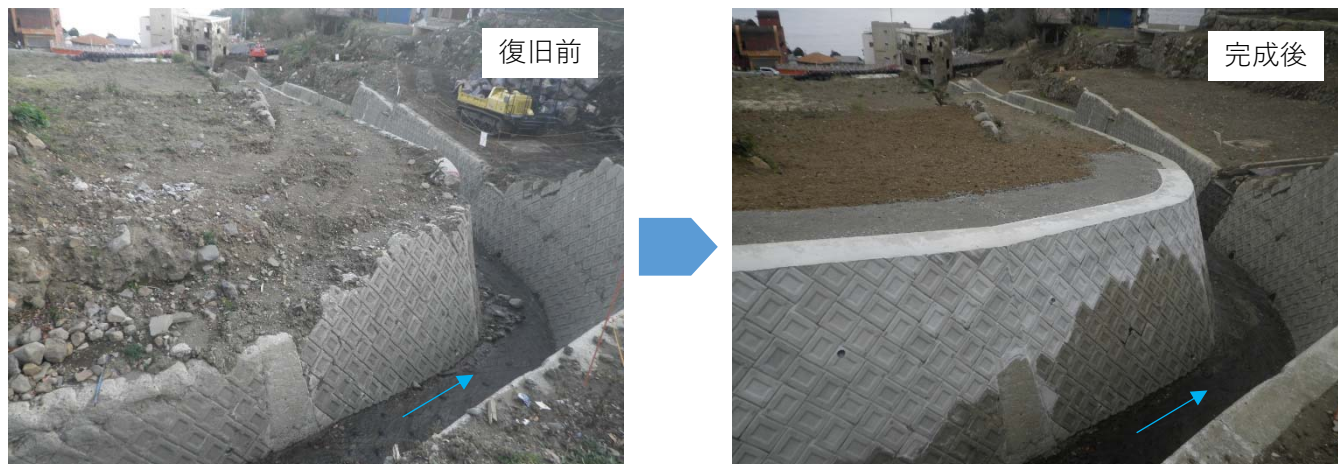
（市道伊豆山神社より約120m上流の逢初川の復旧状況、完成後は令和4年3月時点）
