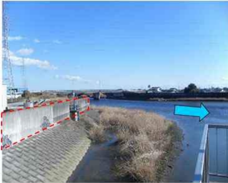
図 1.18 津波対策（河口から2.2km, 芳川）
