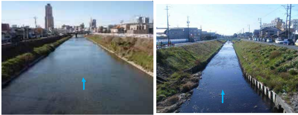
馬込川中流部（河口から9.0km付近） 芳川（馬込川合流点から7.4km付近）
