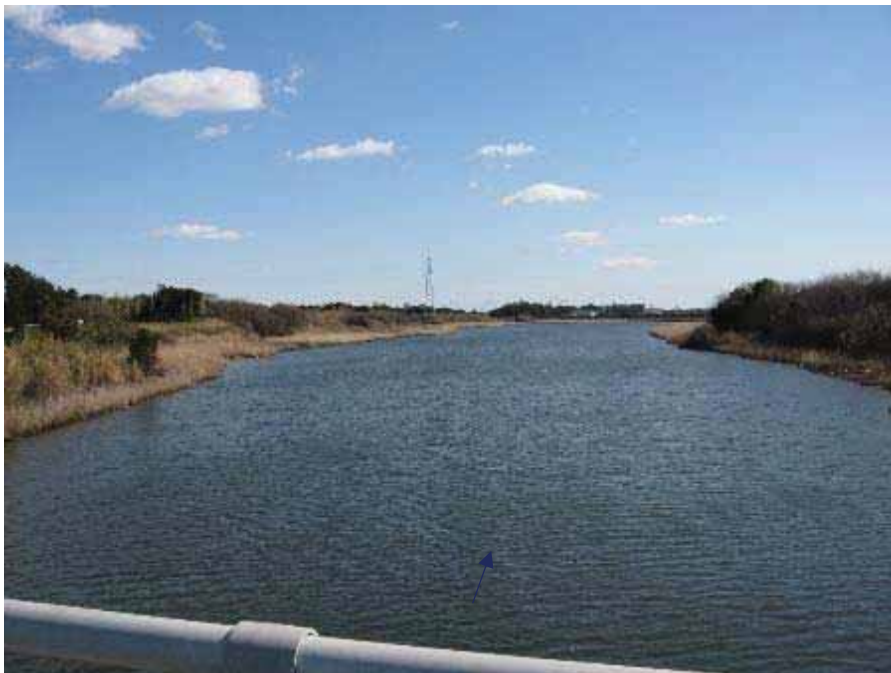
図 2.19 馬込川 中田島橋付近の様子
