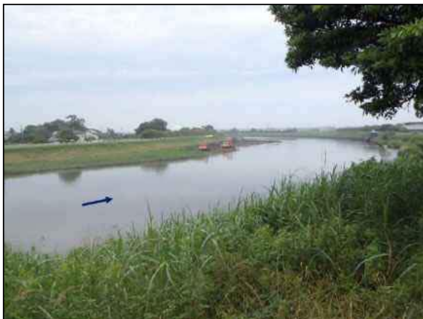
図 4.9 馬込川 下流部における堆積土砂撤去の様子
