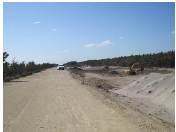
完成した工事用道路と基礎掘削の状況（その2）
