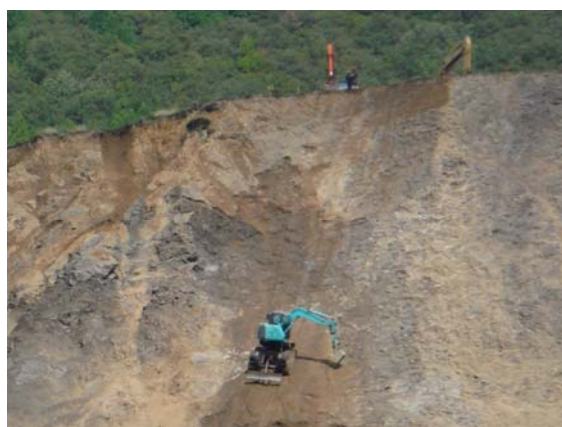
高所法面掘削(10月17日撮影)
