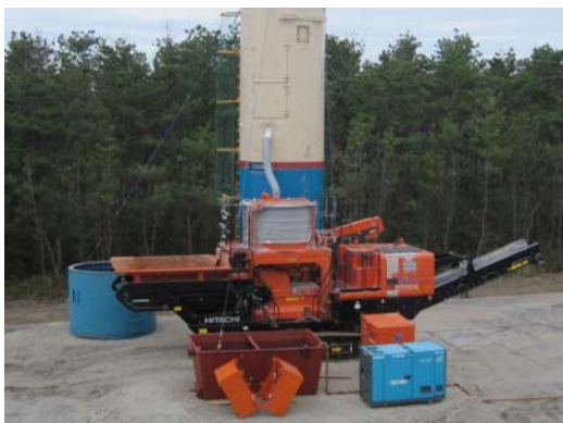
移動式混合機設置状況（CSG 製造）
