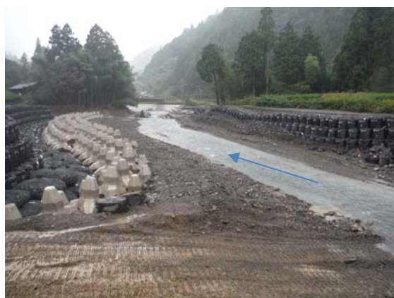
仮排水路の応急対策(10月15日撮影)
