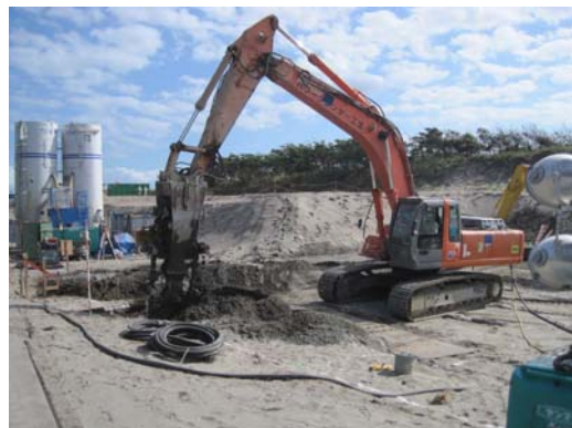
地盤改良施工状況（その 1）
