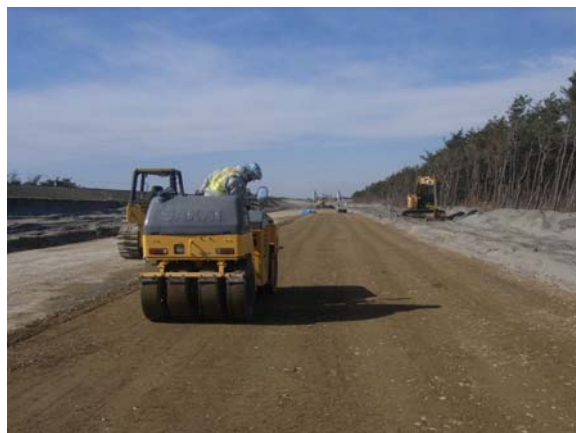
C S G 施工状況：試験施工その 2
