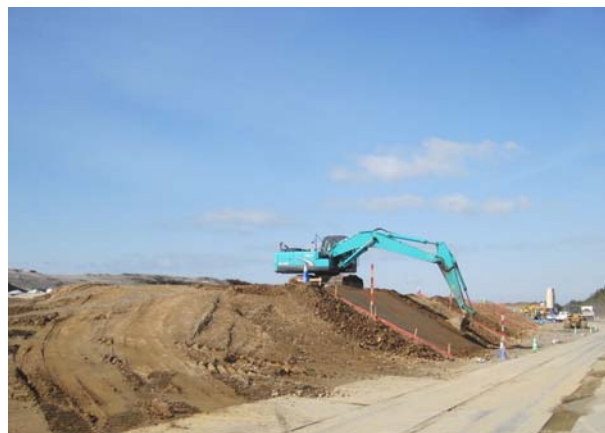
C S G 施工状況：試験施工その 1
