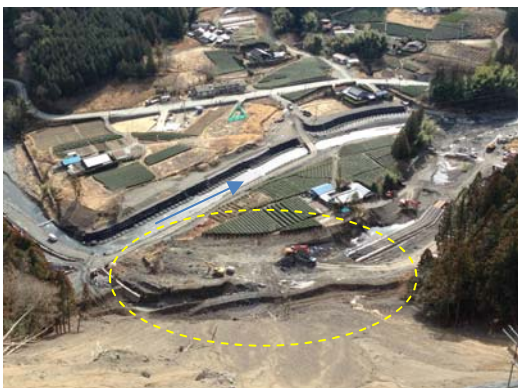
土堤を設置した本川(2月10日撮影)
