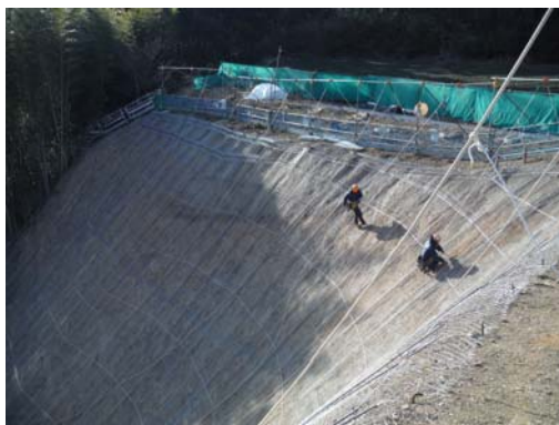
法面工(法枠組立)(2月5日撮影)
