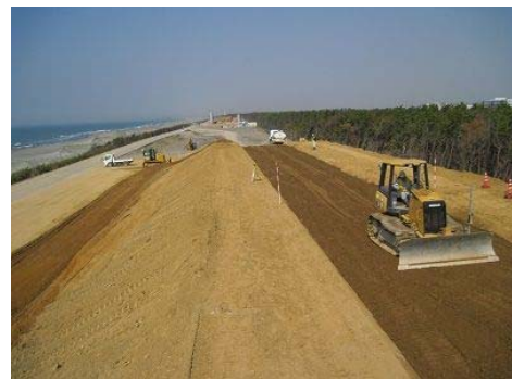
CSG打設状況（試験施工時）
