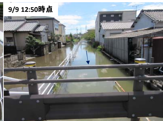
新津橋下流右岸水路(新橋1号排水路合流点)
