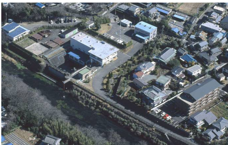
堂庭取水場（清水町）
