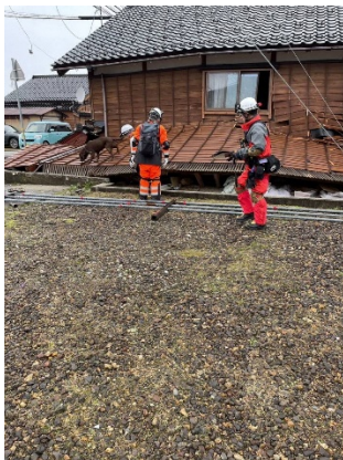
倒壊家屋の搜索 瓦がとても滑りました
