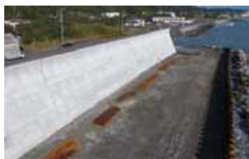
防潮堤の整備
