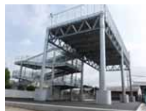
津波避難タワーの整備
