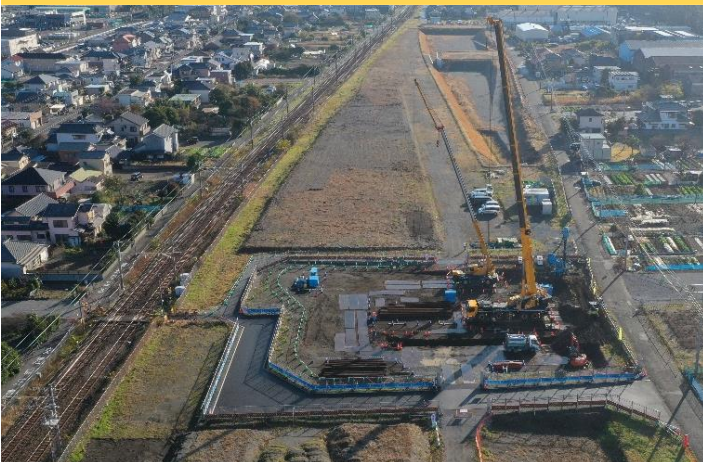
鋼矢板で土を留め、地面を掘る準備をしています
