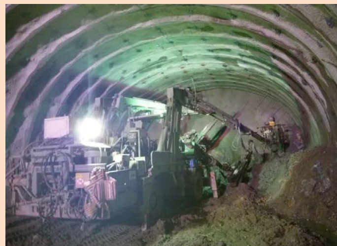
ロックボルトを施工している写真
