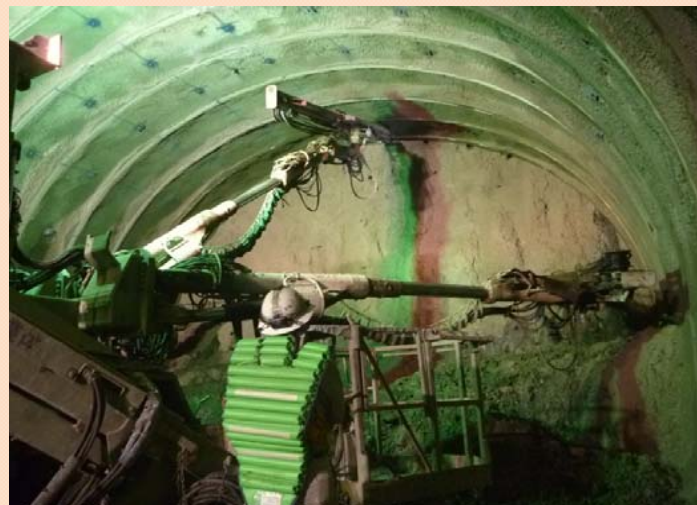
爆薬を入れる穴を削孔している写真
