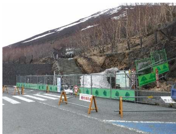
閉鎖状況（五合目）令和4年4月撮影
