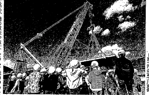
工事現場に到着した巨大型のクレーン。上野市の富士川東側
