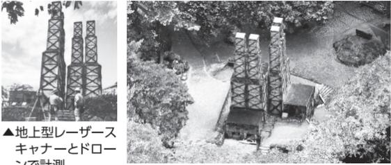
▶地上型レーザーキャナーとドローンで計測 ▶計測した3次元点群データ
