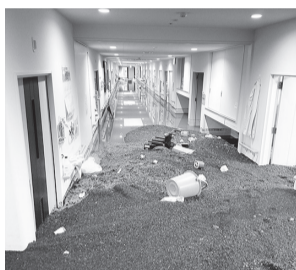
▲施設内に流れ込んだ土砂
