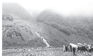
赤崩(代表的な崩壊地)
