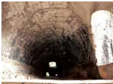
炉体内部をのぞくと天井がドーム状になっているのが見える。黒い部分は煤が付着したところ。稼働したことを示す痕跡だ。
