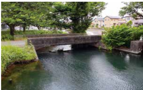
中郷温水池で温められた源兵衛川の水は4基の水門から周辺の水田へ供給される。
