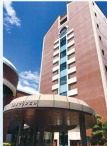
プロジェクトの中核拠点施設「MaOI-PARC」を清水マリニビル2階に整備。
