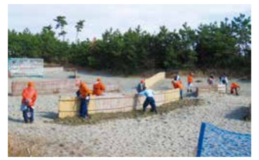
堆砂垣設置の様子。砂が垣根にぶつかって溜まることで砂丘が高く保たれる。
