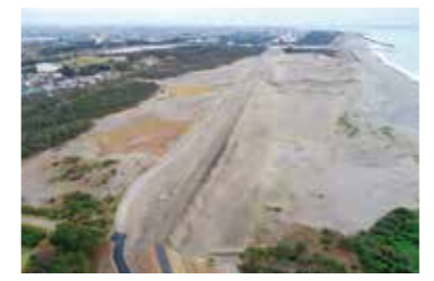
総延長17.5kmの浜松市沿岸域防潮堤。浜松市沿岸を津波被害から守る。
