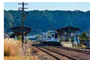
東の掛川駅から西の新所原駅まで全線にわたり、36件にも及ぶ国の登録有形文化財が存在する。
