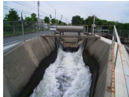
国営かんがい排水三方原用水事業 導水幹線7号分水工
