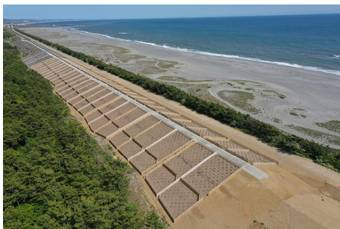
写真4 森の防潮堤づくりの防災林造成
