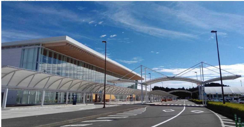
富士山静岡空港旅客ターミナルビル
