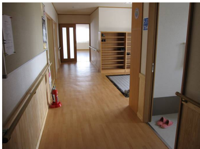
手すりの設置・バリアフリー化
