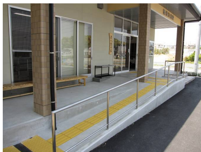
スロープと点字ブロックの設置
