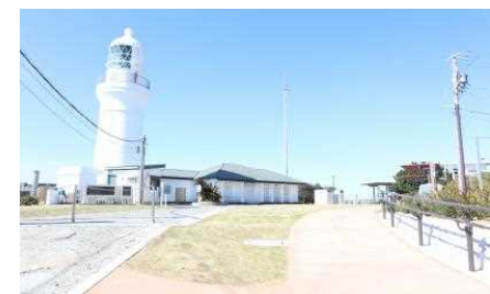
灯台周辺施設整備完了
