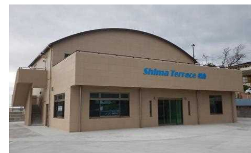
初島漁港交流広場・休憩施設
