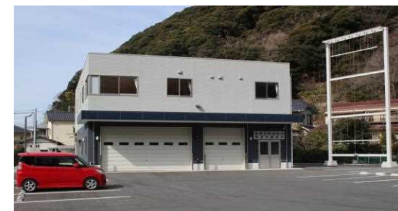
消防団詰所整備完了
