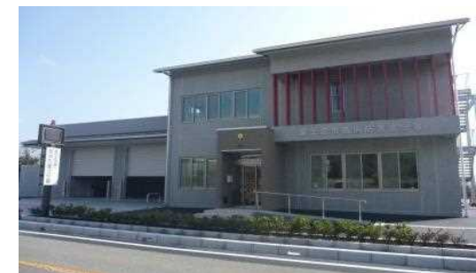
西消防署北分署の建設
