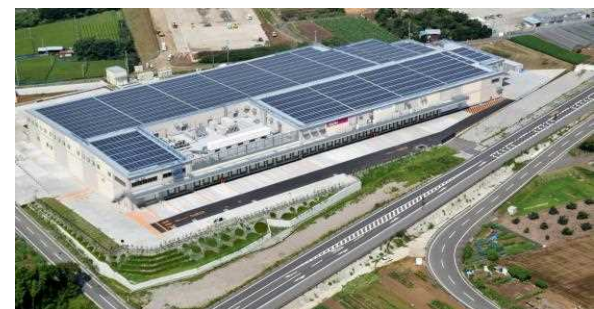
災害に強い物流施設
