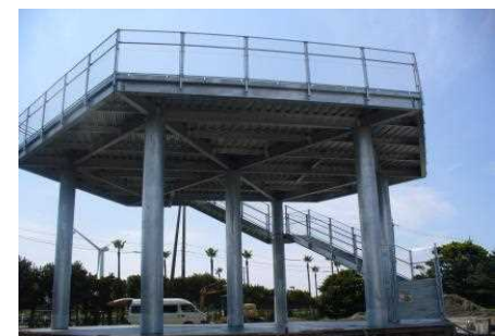
津波避難タワー
