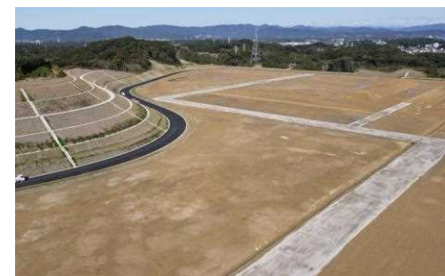
浜名湖西岸地区造成状況
