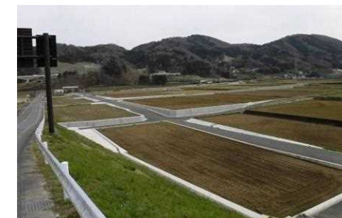
農業基盤整備完了
