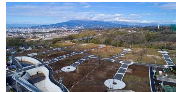
三島塚原地区住宅団地造成完了
