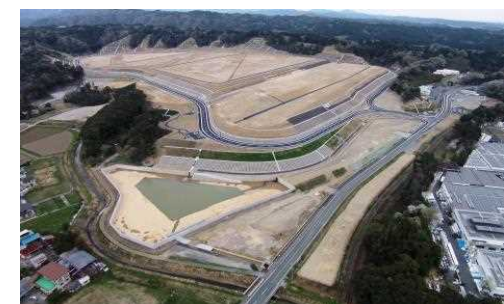
下野部工業団地造成完了
