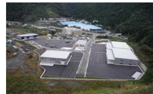
整備された物流団地
