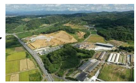
工業団地造成状況
