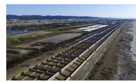
防潮堤の整備
