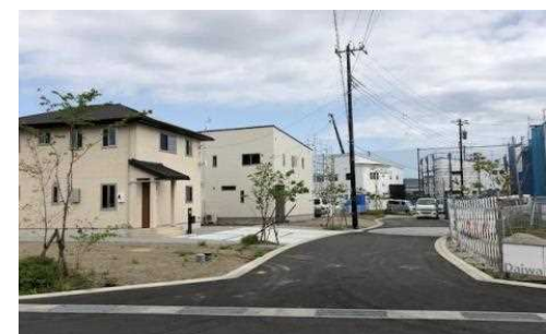
大場地区住宅団地
