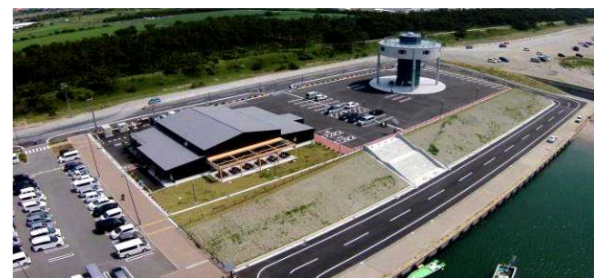
渚の交流館と津波避難タワー
