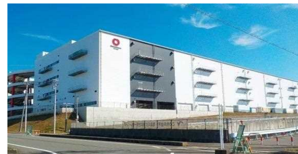
完成した大規模物流施設
