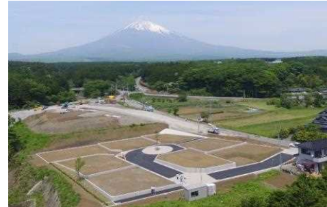
造成が完了した住宅地
