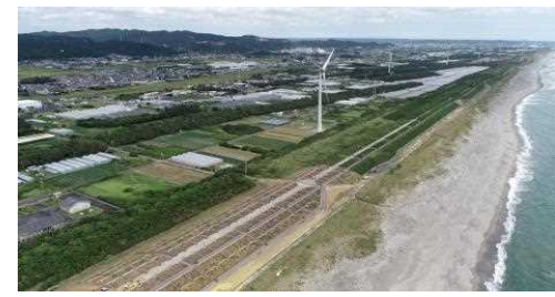
防潮堤整備状況
