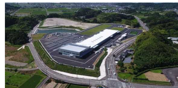
西工区(大坂・土方工業用地)整備状況
