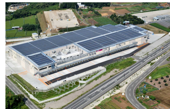
災害に強い物流施設
