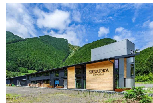
地域資源(麦芽、仕込み水)を活用したウイスキーの製造工場
