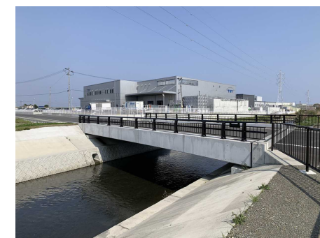
工業団地整備完了
