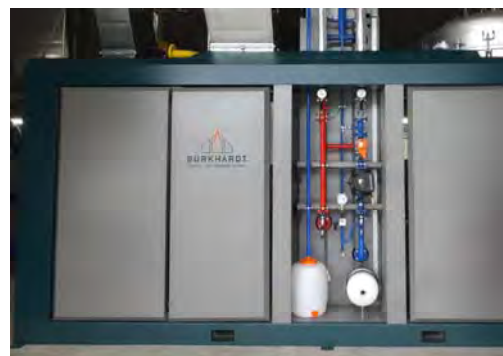
本格稼動する木質ペレットガス化熱電供給装置（小山町）
