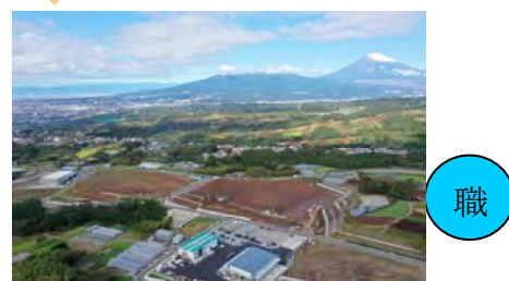
完成した三ツ谷工業団地（三島市）
