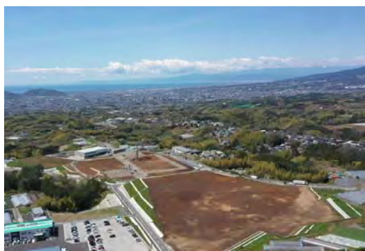
完成した三ツ谷工業団地（三島市）
