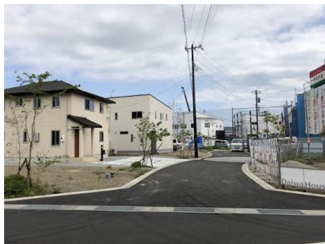
建築が進む 住宅団地(大場)
