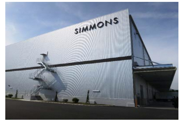
建設された物流施設
