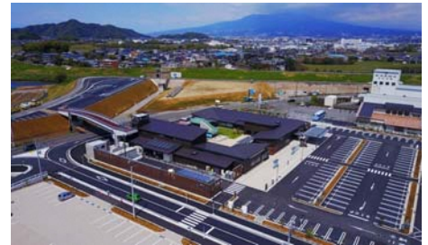
完成した道の駅
