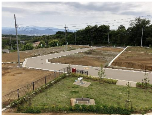
整備が完了した 住宅団地(市山新田)
