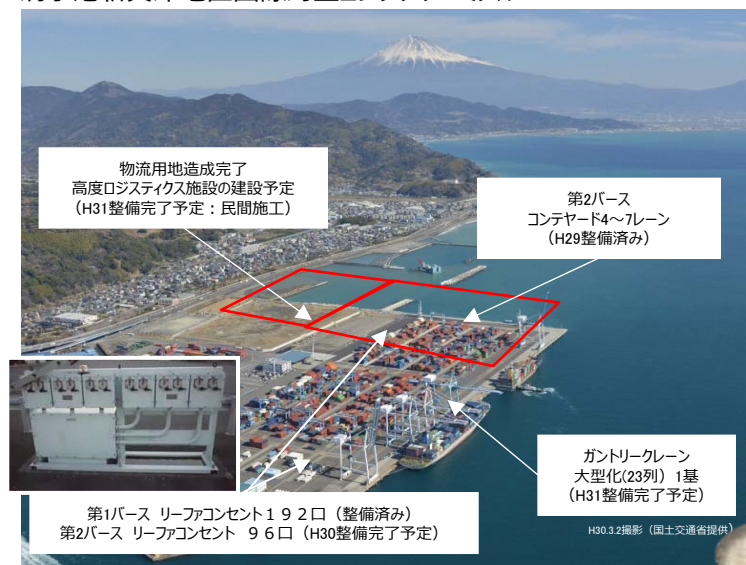
清水港新興津地区国際海上コンテナターミナル
