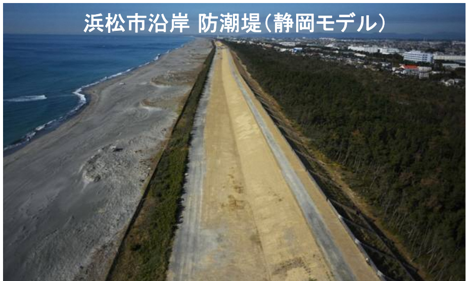
浜松市沿岸域の防潮堤の整備状況
