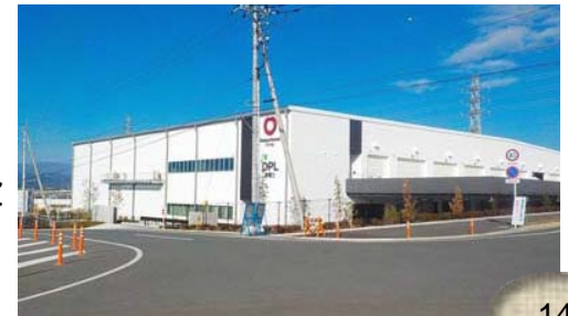
完成した マルチテナント型物流施設
