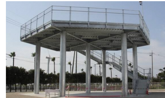
津波避難施設
