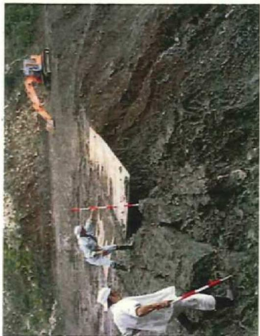
雨水により、開発地の転圧不足の土砂が流れ出ていることを確認。
