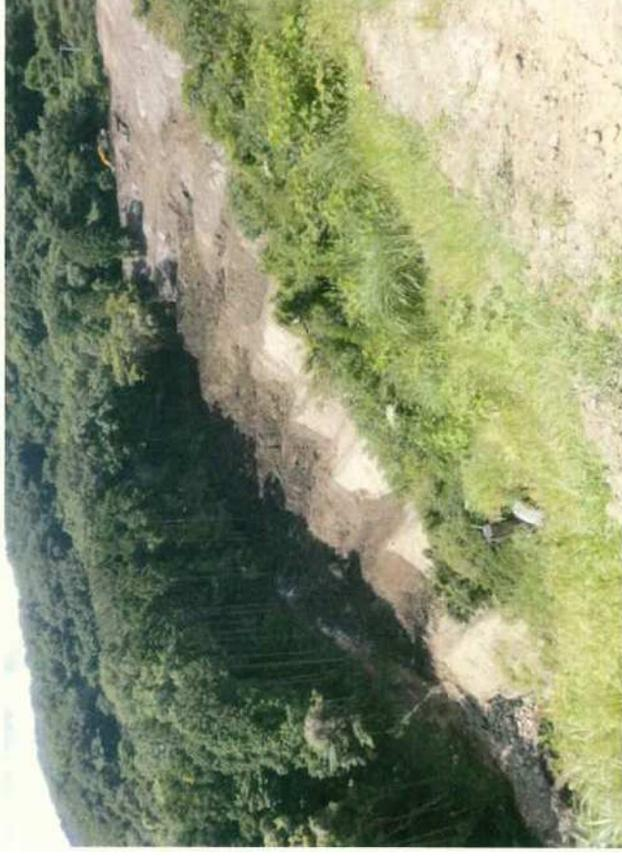
盛土はすでに8～9段行われている。盛土の下部の土留は、2007年5月22日撮影のもの（基本構造（転石土留＋土留柵）と同じである。
