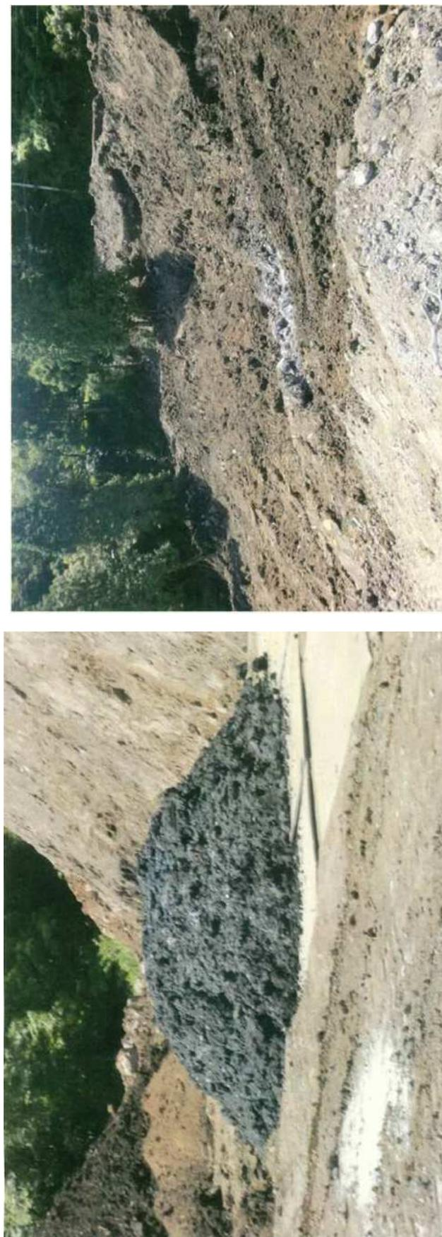
残土処分場の上部にへドロのようなものが置かれている。最上部は崩落したものである。
