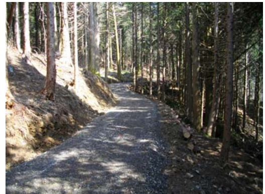
完成した作業道
