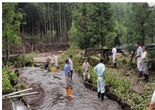
災害発生後の状況
