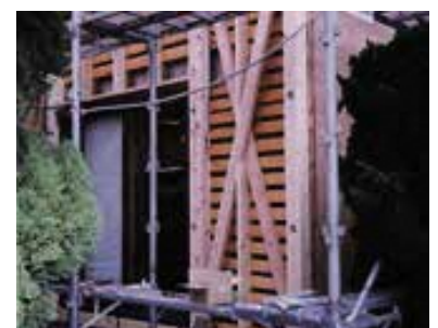
木造住宅耐震補強
