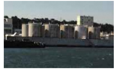
御前崎港防潮堤（胸壁）
