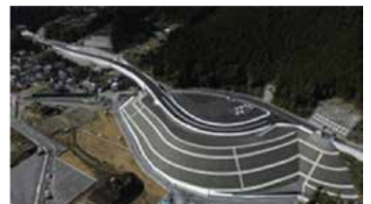
三遠南信自動車道(水窪佐久間道路)
