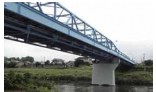
(一)下土狩徳倉沼津港線 徳倉橋
