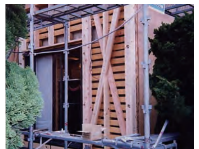
木造住宅耐震改修
