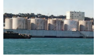
御前崎港海岸防潮堤（胸壁）
