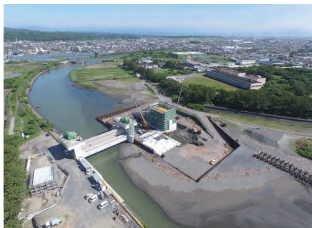
坂口谷川（水門）
