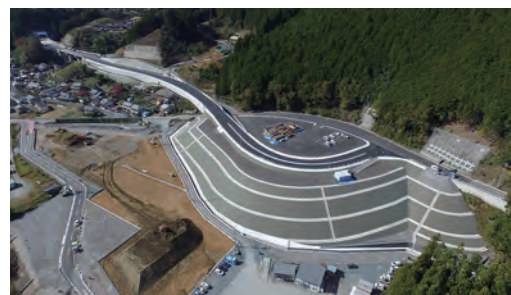
三遠南信自動車道(水窪佐久間道路)
