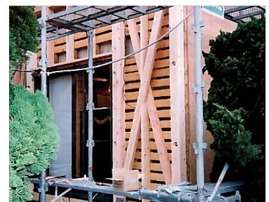
木造住宅耐震改修
