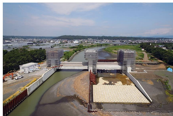
坂口谷川（水門）
