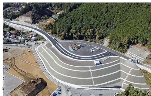
三遠南信自動車道 (水窪佐久間道路)
