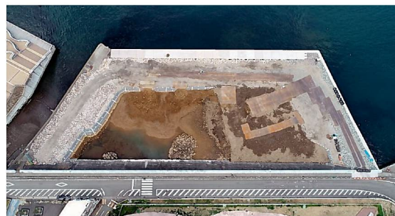
熱海港海岸（海岸堤防）
