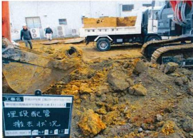
埋設配管撤去状況
