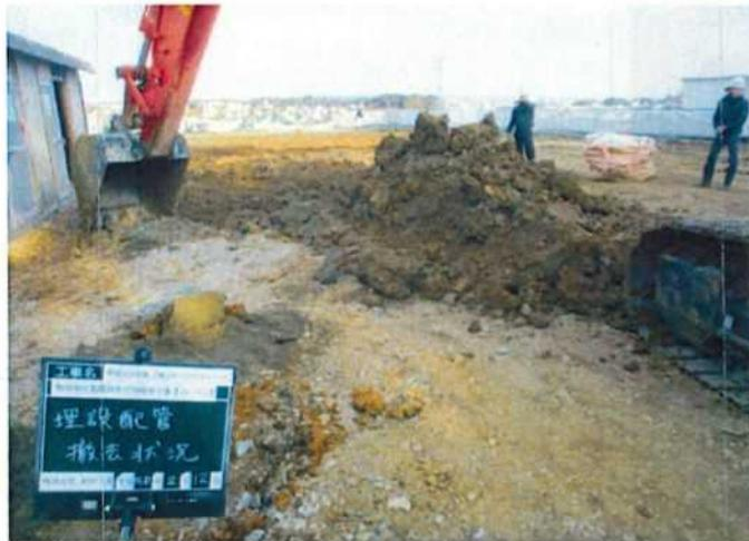
埋設配管撤去状況
