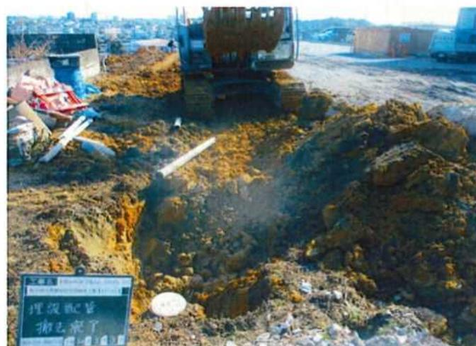
埋設配管撤去完了
