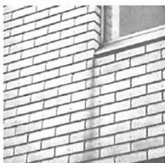
水皿皿板端部に集まった汚染水の排水経路がないため、外壁面を汚染水が流れ汚れが付着したもの。
