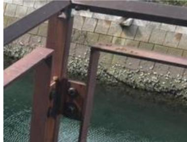
塩害地域の溶融亜鉛メッキリン酸処理(築12年)のフェンスの発錆事例
