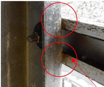
塩害地域にて、ルーバー (アルミ型材) と胴縁 (溶融亜鉛メッキ) の間で電気腐食が発生した例
