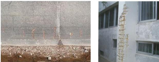
中性化によるひび割れ 塩害地域の中性化※1
