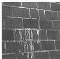
モルタルの調合が適切でない場合、目地部から浸入した水とセメント成分が反応することによって、エフロレッセンスが生じる。
