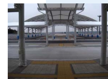
屋根のある身体障害者用駐車場(奥側)
