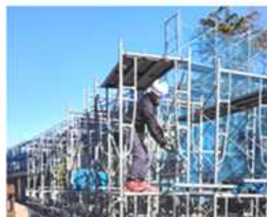
Montagem dos andaimes e tapumes para ajudar na construção
