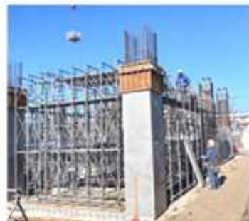
Um andaime seguro é uma das bases de uma boa construção
