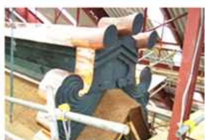
Cobertura de chapa de cobre nas extremidades das telhas do telhado.
