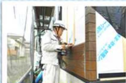
Serviço de cobertura de muro exterior com chapa metálica
