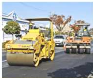
Pavimentação com grandes máquinas
