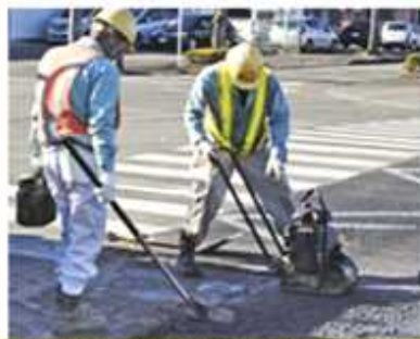
Trabalhos minuciosos requerem mais habilidades dos trabalhadores
