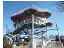
つなみひなん 津波避難タワー
