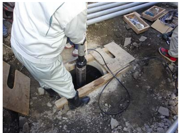
井戸ポンプ設置の様子
